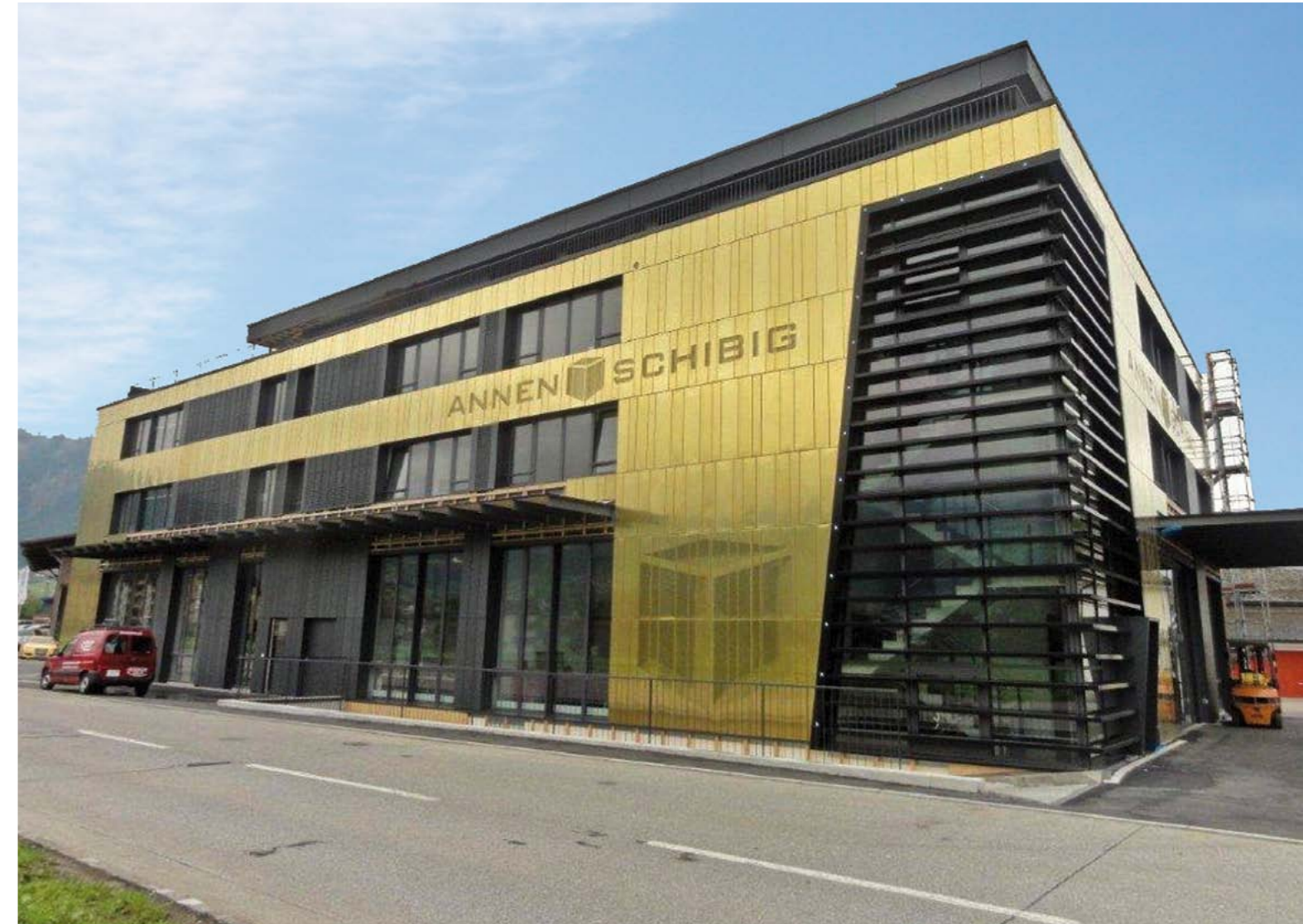
In der Fassade des Neubaus der Annen + Schibig AG sind PV-Module zwischen den Fensterflächen gestalterisch anspruchsvoll integriert.
