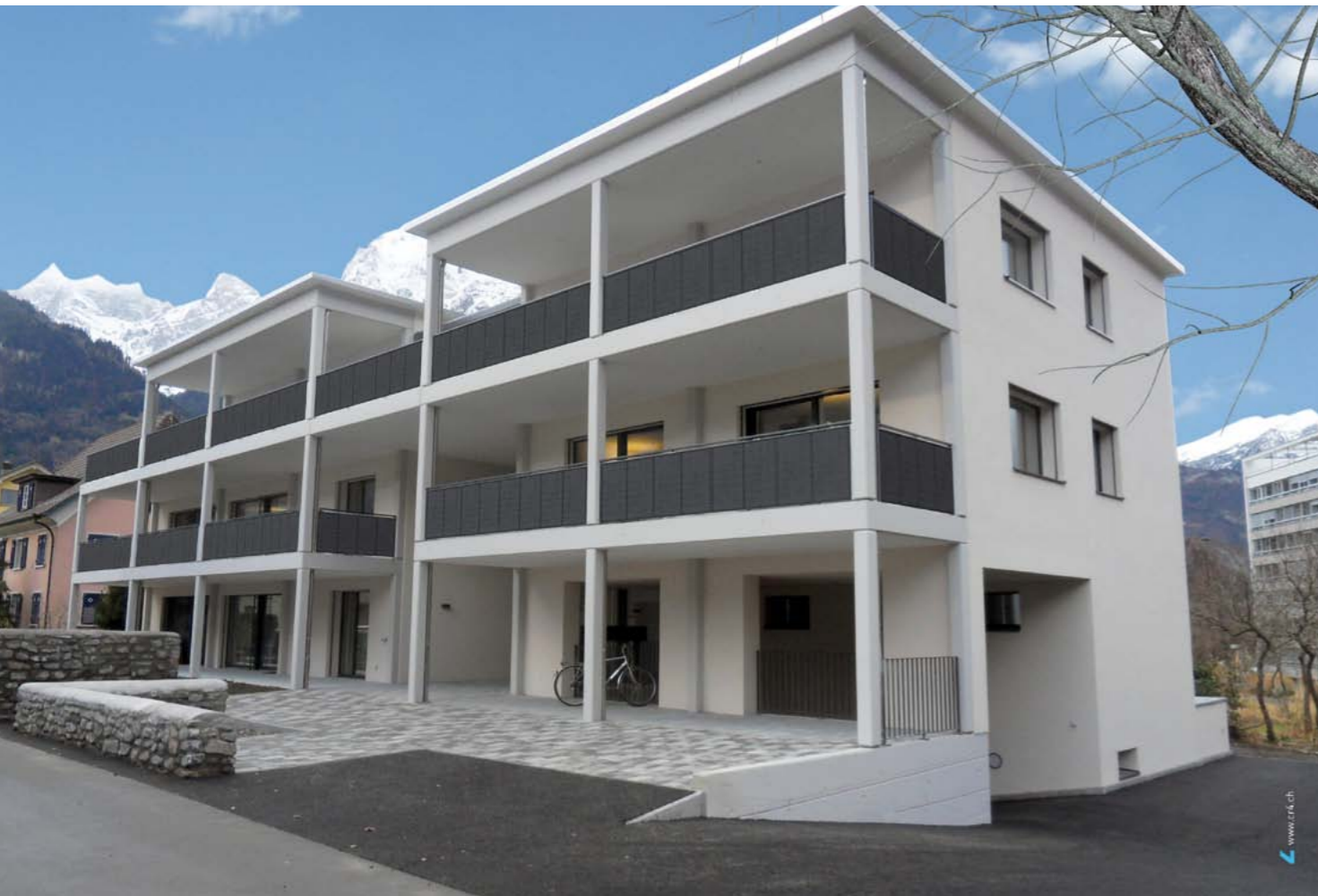
Mehr als zwei Fliegen auf einen Schlag: Das PV-Modul dient als Sicht- und Absturzschutz, gewinnt Strom und finanziert mit dem Ertrag sowohl die PV-Anlage als auch das Balkongeländer!
